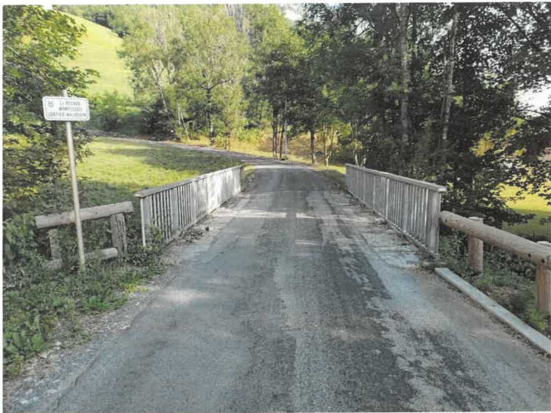
Affaissement en rive de chaussée
