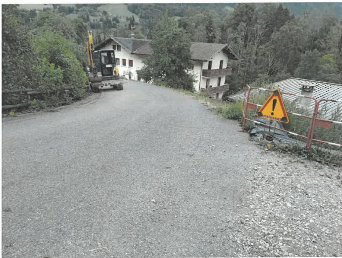
Affaissement en rive de chaussée
